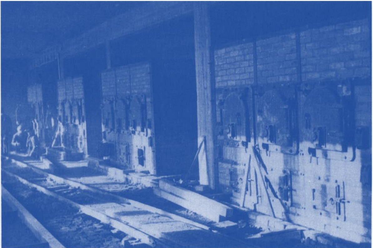
Die Öfen der Zwillingskrematorien II und III im Bau, links Häftlinge bei der Arbeit.
