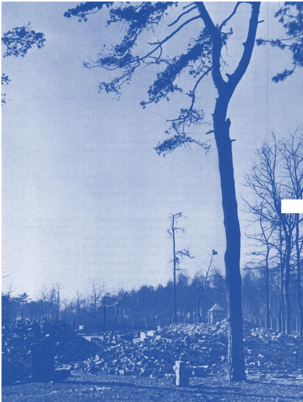
Die Trümmer des Krematoriums V, das von der SS am 26. Januar 1945 gesprengt worden war.
