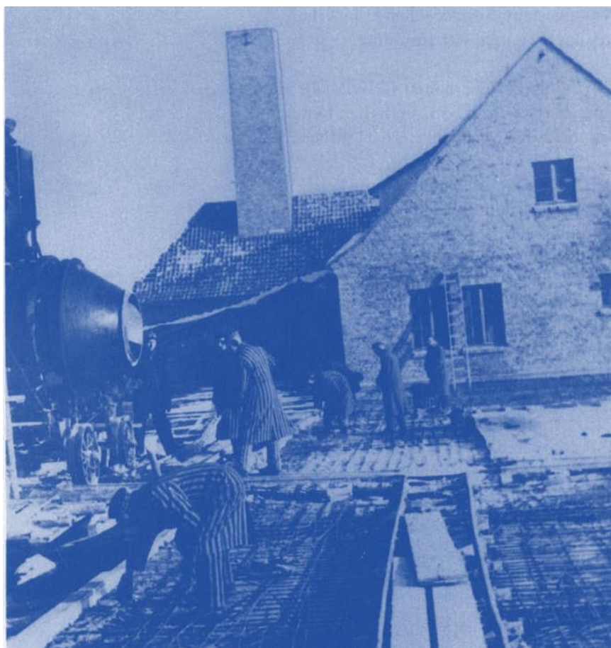
Häftlinge im Februar 1943 beim Bau der Kellerdecke des zum Krematorium II gehörenden «Entkleidungsraumes».
