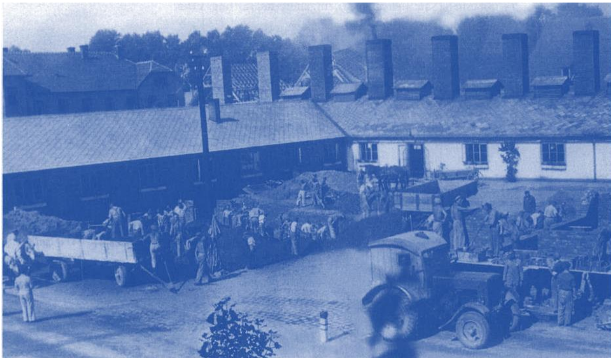
Häftlinge im Herbst 1943 beim Erweiterungsbau des Küchegebäudes.
