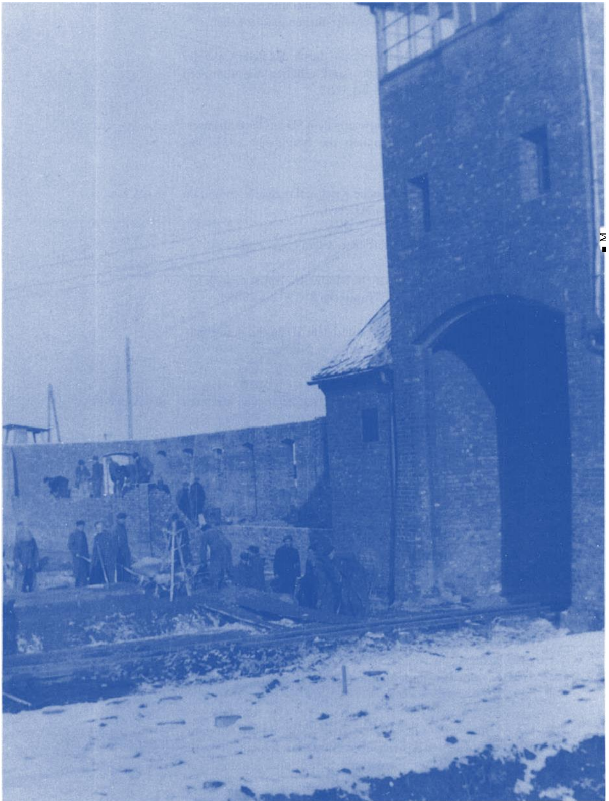
Die Trafostation in Birkenau im Bau.
