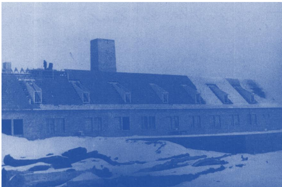
Das Krematorium II kurz vor der Fertigstellung, vorn rechts der Keller mit den Gaskammern.
